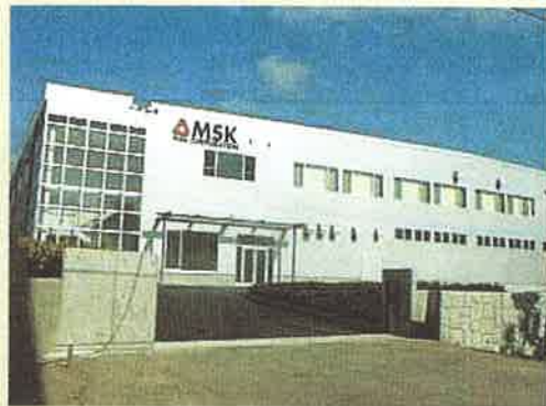
世界最速モジュール化ラインを設置した新佐久工場
